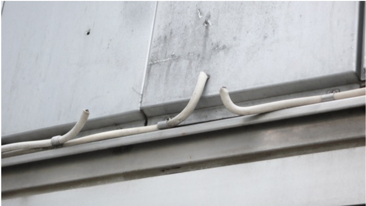
Bild 3. Löst hängande kablar gavel mot öst ovan affärsplan.
