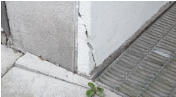
Bild 10. Sprucken och trasig puts samt sockel förkommer i och runt entréer.
