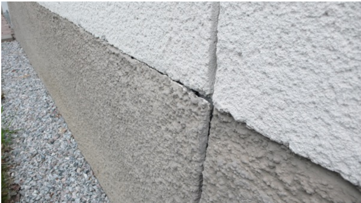
Bild 7. Löst sockelparti med öppen anslutning.
