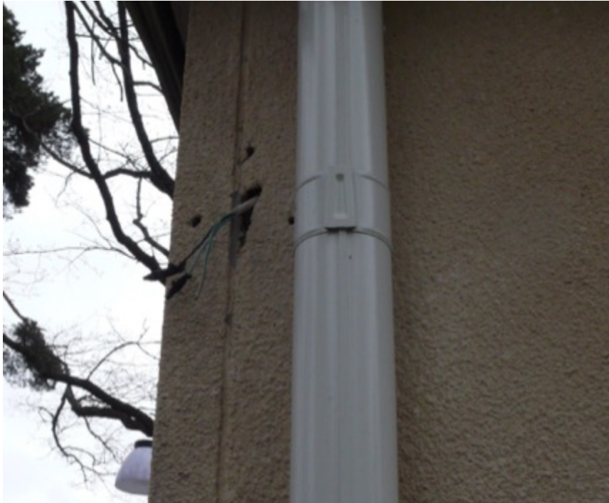
Bild 17. Lösa kablar och hål i puts efter armatur.
