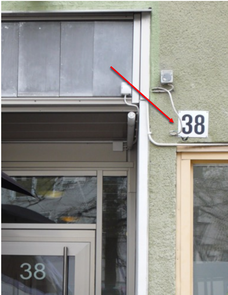
Bild 7. Löst hängande kabel.
