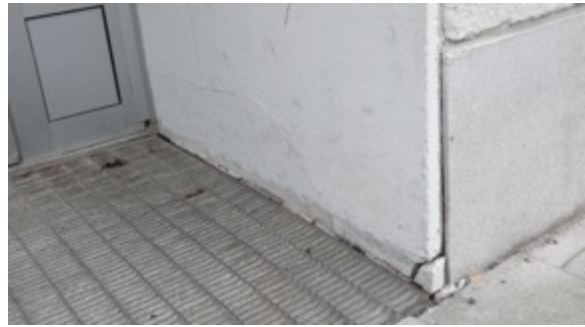
Bild 10. Sprucken och trasig puts samt sockel förkommer i och runt entréer.
