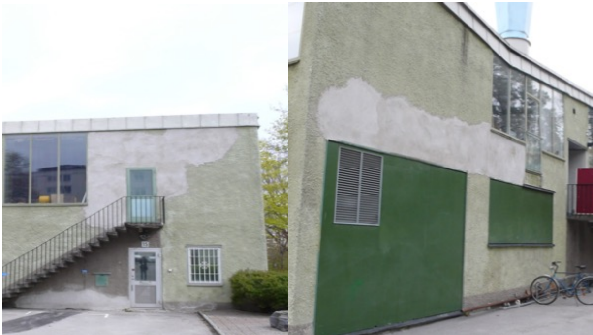
Bild 11. Omfattande bristfälliga putslagningar.
