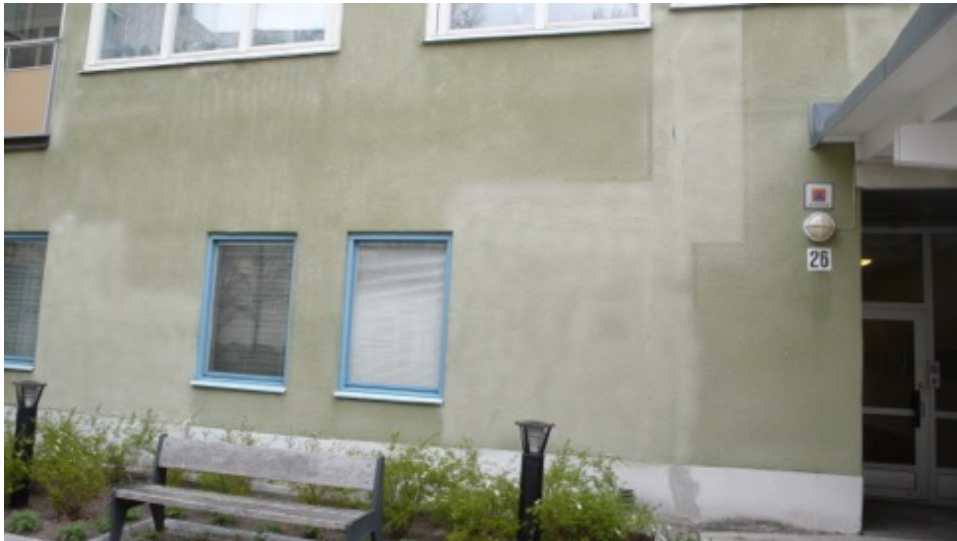
Bild 3. Lagad och renoverad fasad i avvikande nyans.
