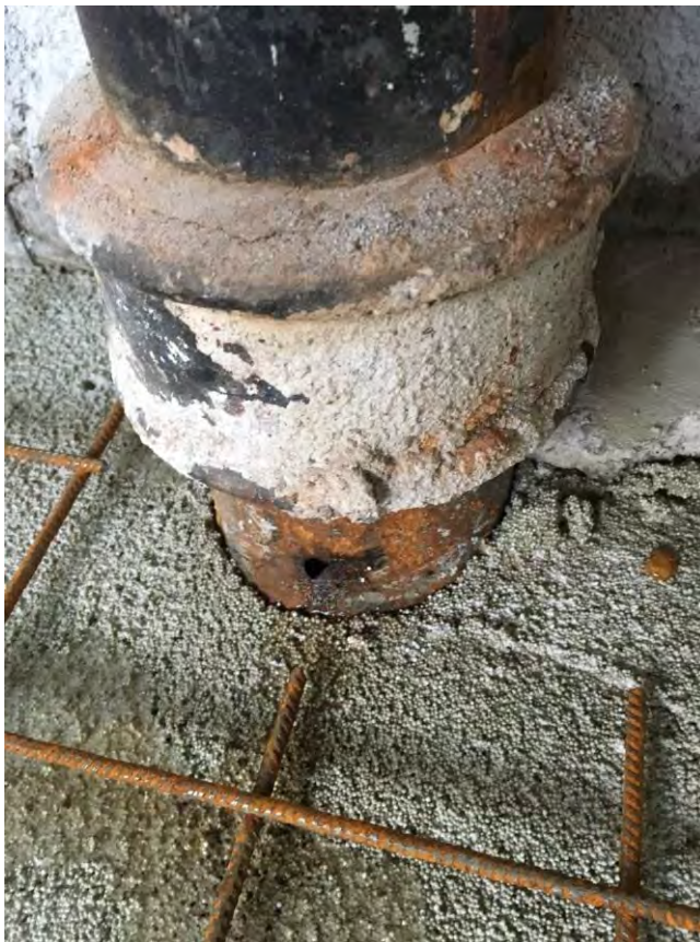
Foto vänster: Vid renovering av lgh stötte armeringsnät mot bef. avloppsrör och orsakade hål. Foto höger: Utbytt del av stamledning med rosthål. Foton ej specifika för Torsken 5.
