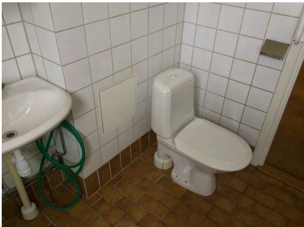
Schaktlucka i badrum till tappvattenstammar.
