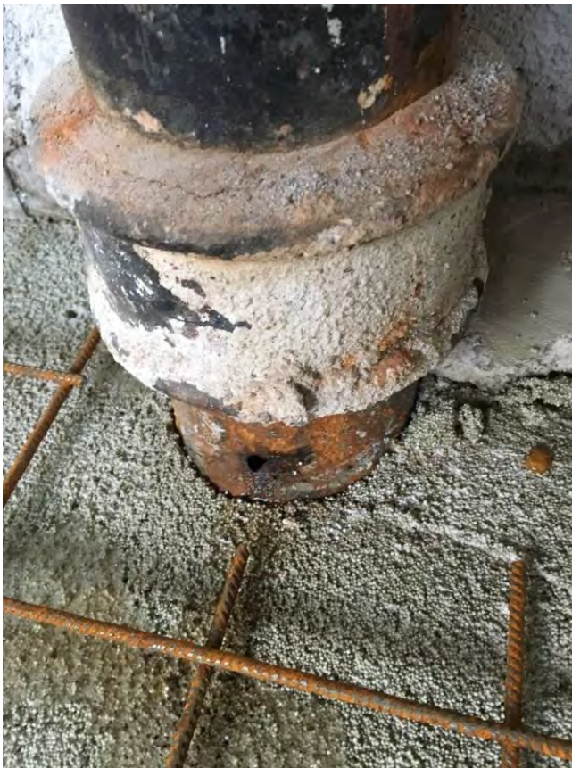
Foto vänster: Vid renovering av lgh stötte armeringsnät mot bef. avloppsrör och orsakade hål. Foto höger: Utbytt del av stamledning med rosthål. Foton ej specifika för Torsken 2.
