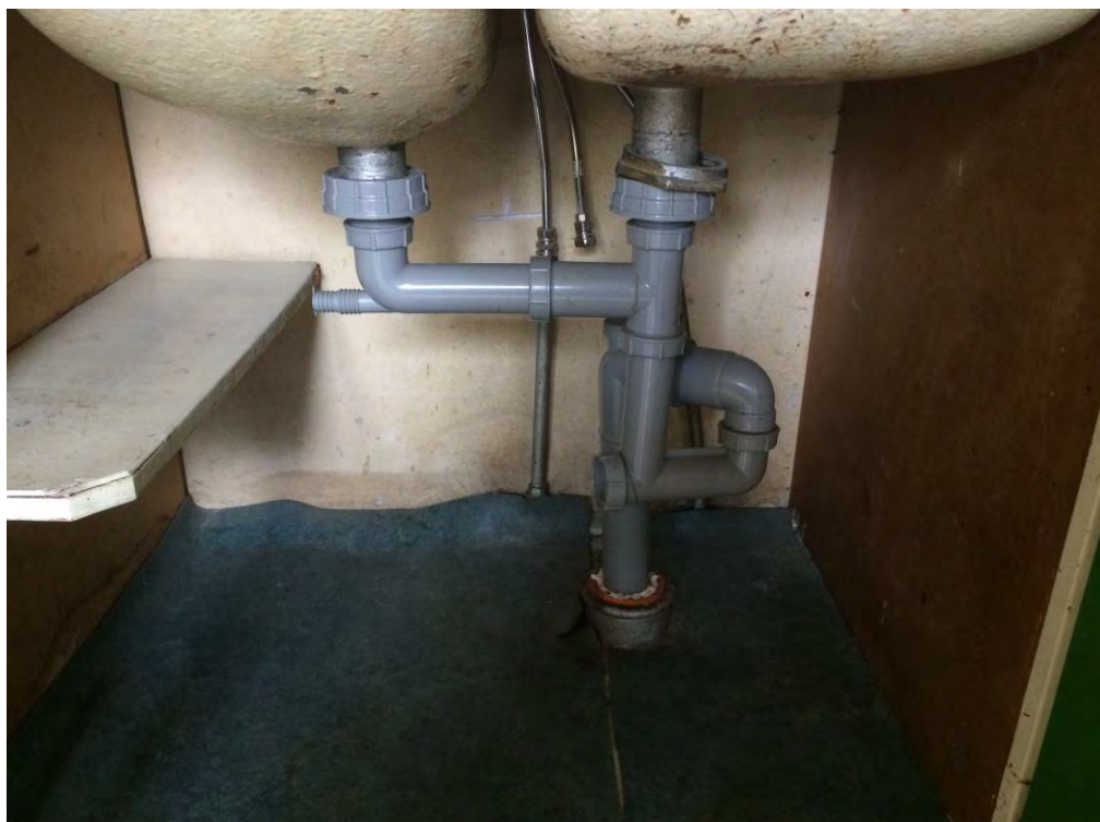
Avlopp under diskbänk, där gammalt vattenlås av gjutjärn bytts till plast.
