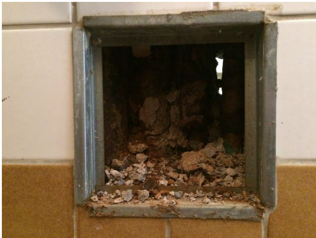
Schaktlucka i badrum till tappvattenstammar.
