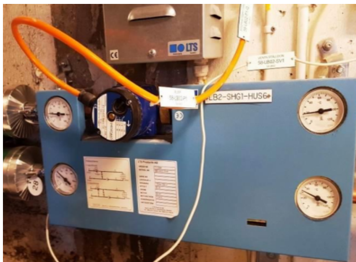
(Bild 18) Bagartorpsringen 58. Shuntgrupp i bottenplan, samma i alla hus.
