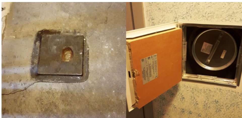
(Bild 30) Bagartorpsringen 70. Renslucka befintlig kanal i bjälklag. Nyare renslucka när tilluft installerades.
