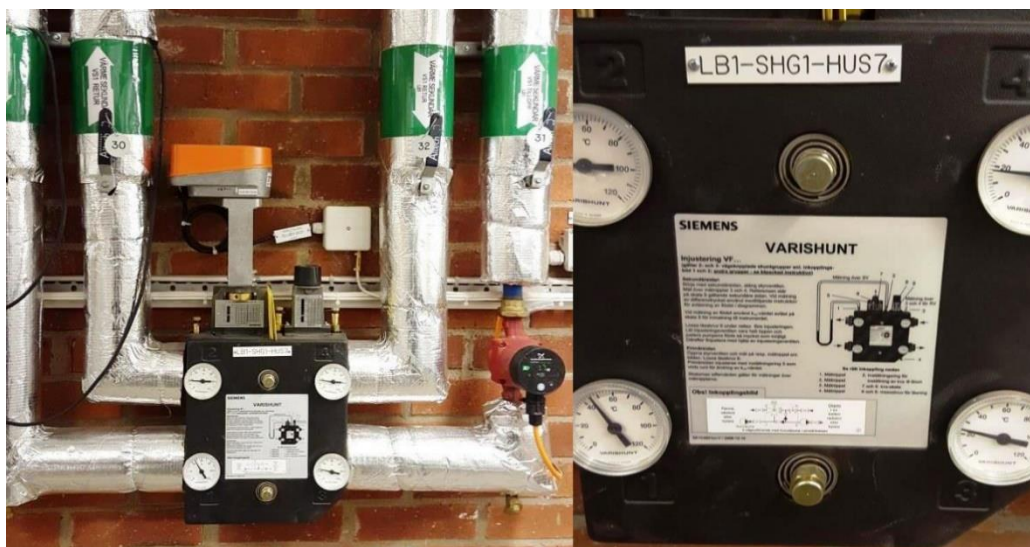
(Bild 22) Bagartorpsringen 62. Shuntgrupp LB1
