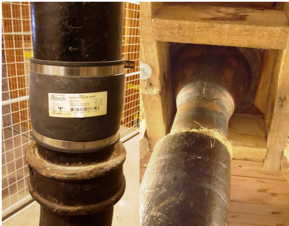
(Bild 11) Bagartorpsringen 70. Vänster: reparerad stam. Höger: takvattenbrunn.
