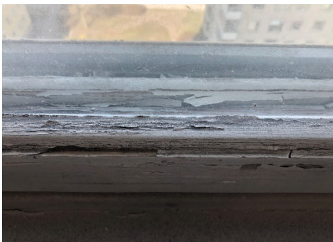
Fönster i lägenhet, sett inifrån.
