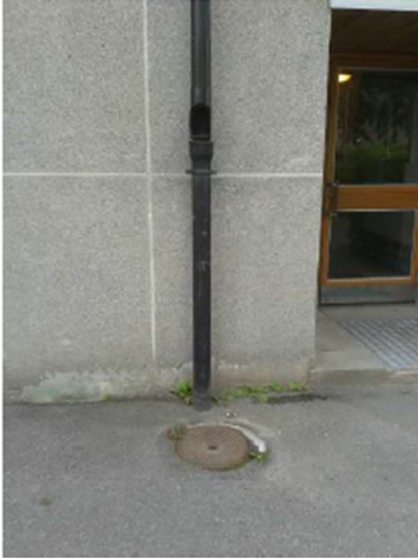
Bild på utvändigt stuprör samt rensbrunn.
