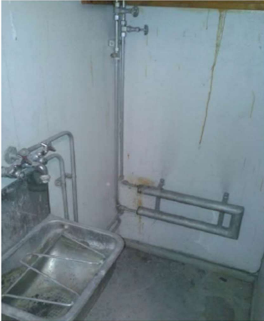
Bild på befintlig sanitetsutrustning från 1960-tal i städutrymme.
