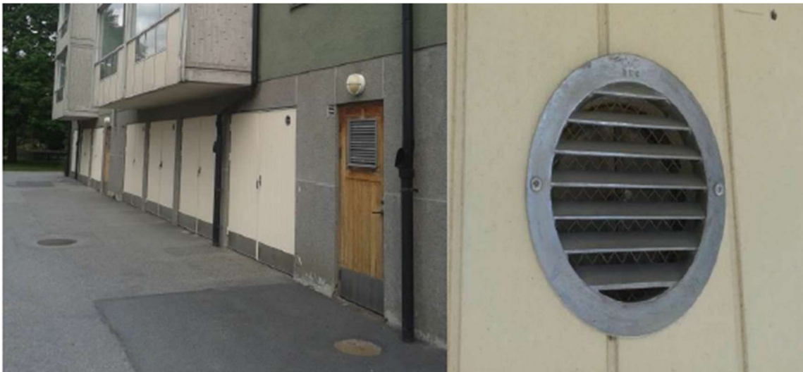
Bild på fasad med stuprör, dörrar till garage samt närbild på ventilationsgaller i garagedörr.
