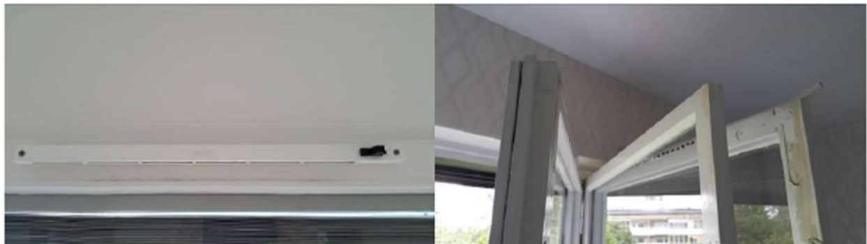
Bild på befintliga friskluftsventiler samt håltagningar i fönsterkarm.
