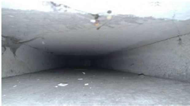
Bild på skick inuti befintlig eternitkanal.
