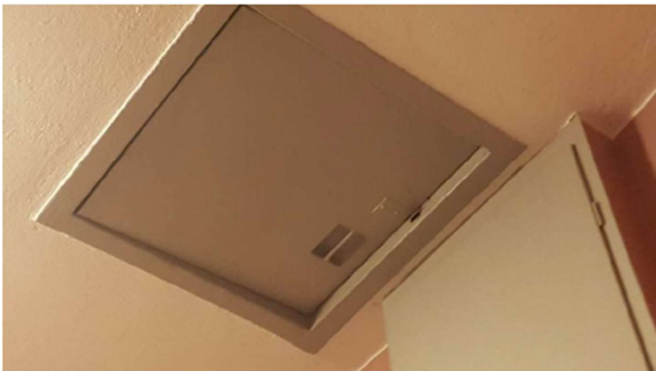
Bild på servicelucka för åtkomst till vind.
