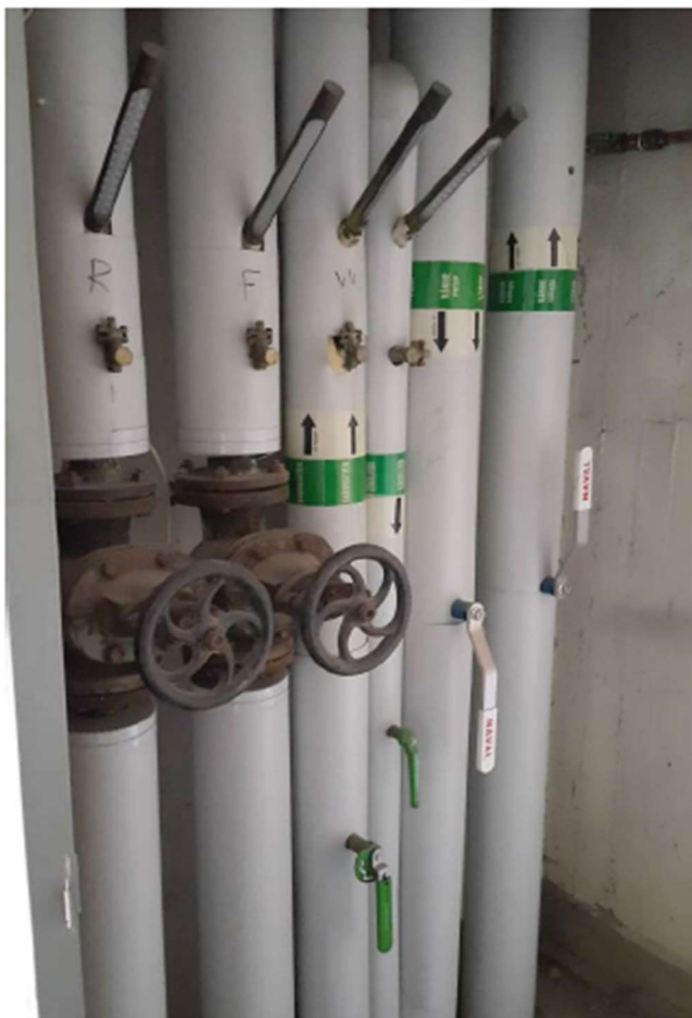
Bild på rörstråk efter uppgång kulvert.
