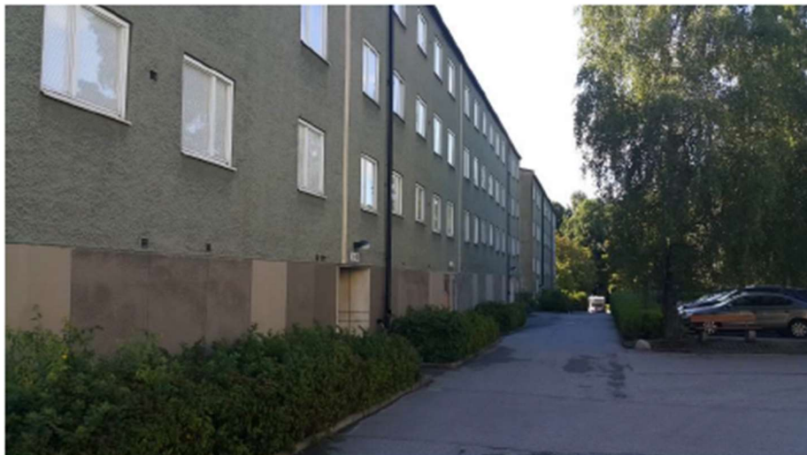
Bild på fasad för hus 1.
