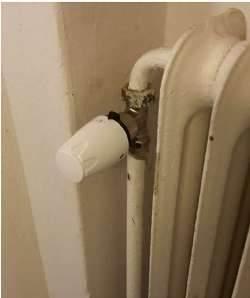
Bild på termostatventil för radiator.
