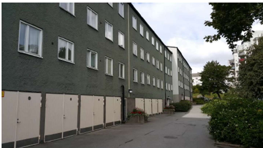
Bild på fasad för hus 3.
