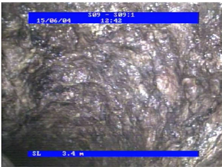
Närbild på vägg till stående S75 spillvattenstam i gjutjärn.
