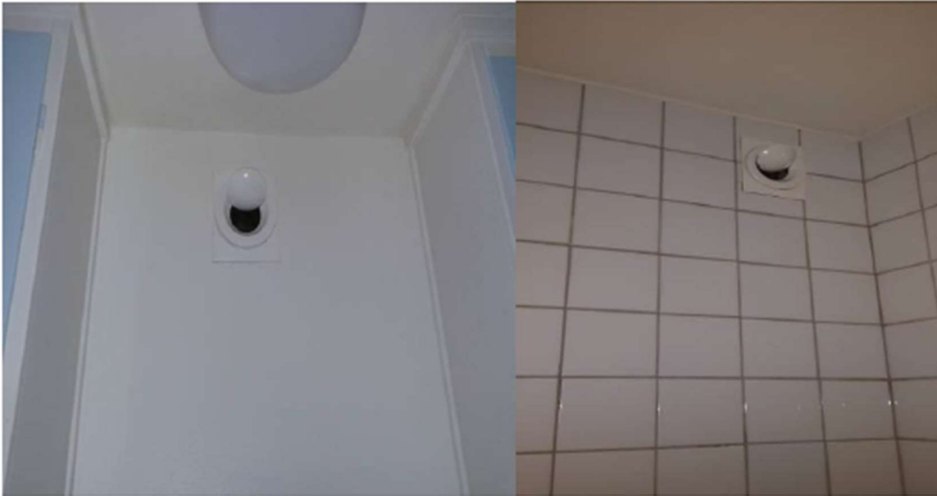
Befintliga frånluftsventiler i kök respektive badrum.
