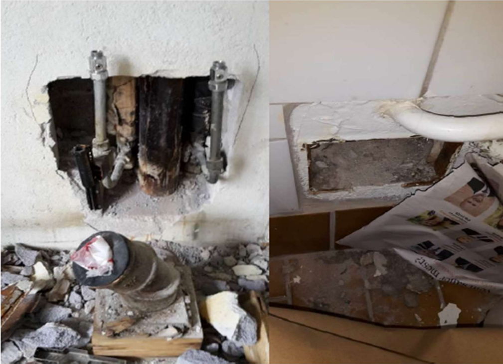
Bild på befintligt schakt i kök respektive badrum.
