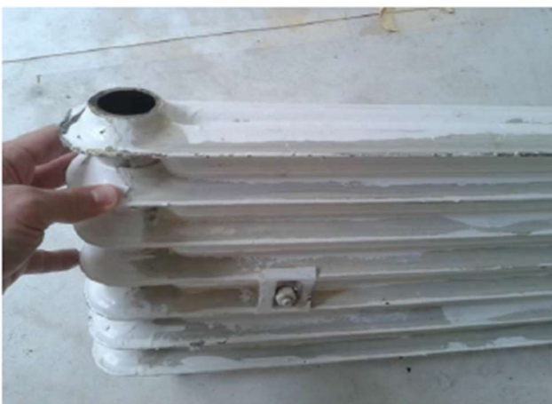
Bild på originalradiator i sovrum itu sågad.
