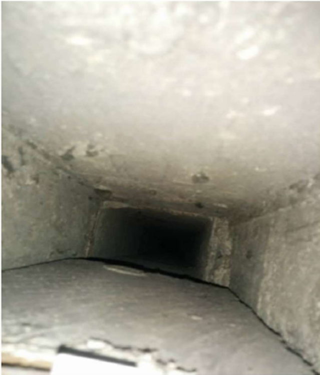
Bild upp i befintlig gjuten ventilationskanal.
