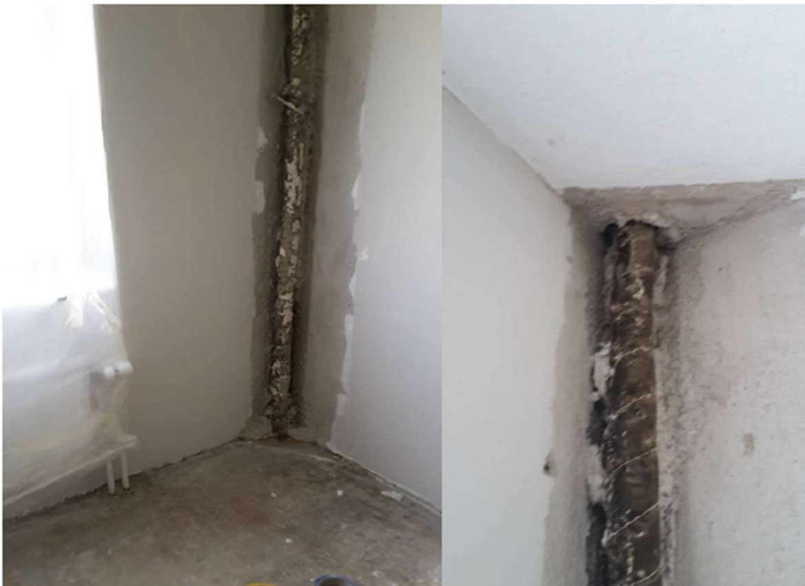
Befintliga värmestammar i lägenhet.
