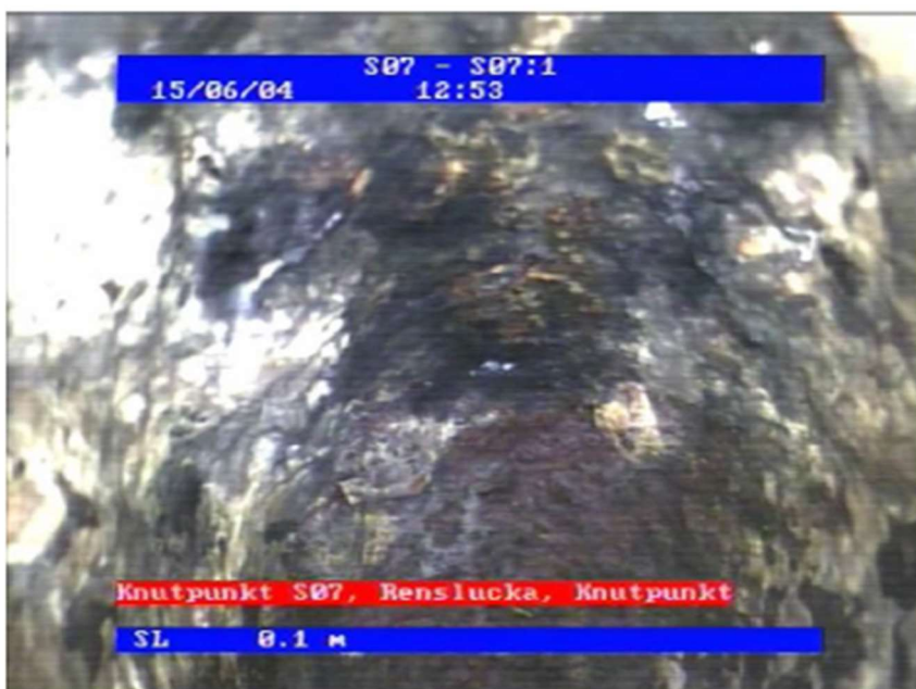
Närbild på vägg till stående S100 spillvattenstam i gjutjärn.
