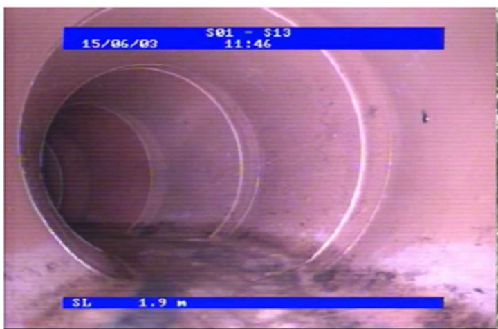
Bild på utbytt anslutande liggande S150 Spillvattenledning i plast utanför huskropp.
