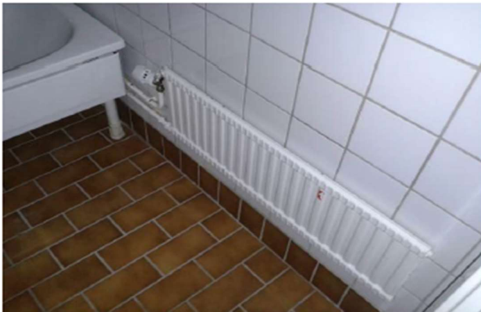
Befintlig panelradiator i badrum.
