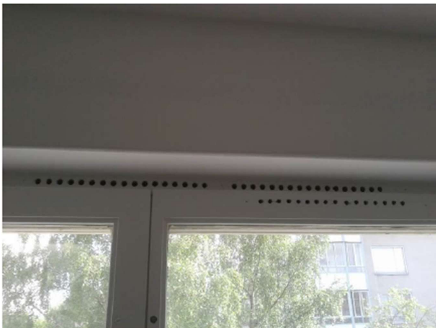
Insida fönster med friskluftsventiler bortmonterade.
