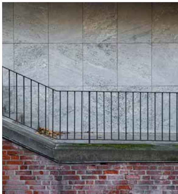
I Bagartorp demonterades marmorplattor från fasaderna för att senare återmonteras i trapphuset på ett av de nya punkthusen.
