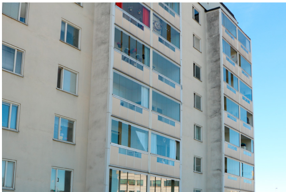
Renovering av kvarteret Gunnarbo i Bagartorp.
